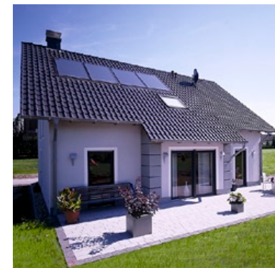
Dom jednorodzinny z systemem solarnym Schüco Premium z dodatkowym wspomaganie centralnego ogrzewania
