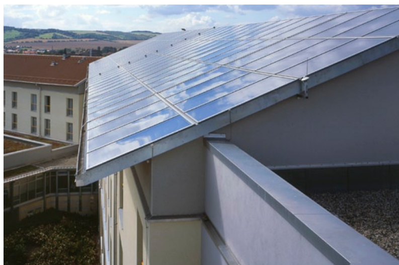
Duża instalacja solarna na dachu kliniki rehabilitacyjnej do ogrzewania wody pitnej, wspomagania centralnego ogrzewania i ogrzewania wody w basenie kąpielowym
