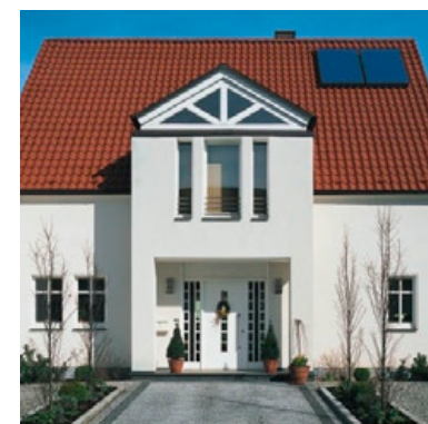
Dom jednorodzinny z systemem solarnym Schüco Compact służącym do przygotowywania ciepłej wody użytkowej
