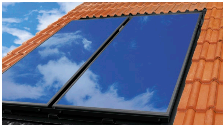
Widok dachu z systemem linii Compact
